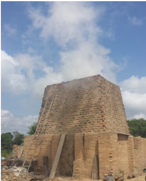
FIGURA 14. Horno ladrillero utilizando la mezcla AQD75/25.
